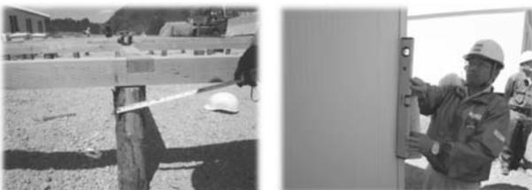
基礎松杭の寸法、固定確認 断熱材の仕様確認等 建物の水平、垂直確認 住戸界壁の仕様確認等
