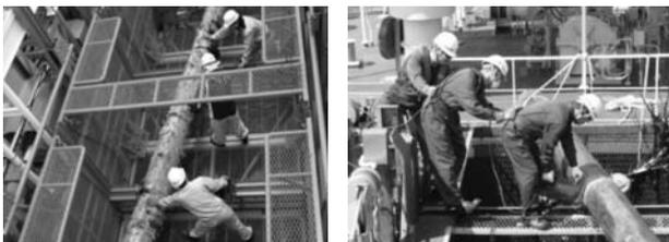
写真-4 流木の回収（陸揚げするための切断作業）
