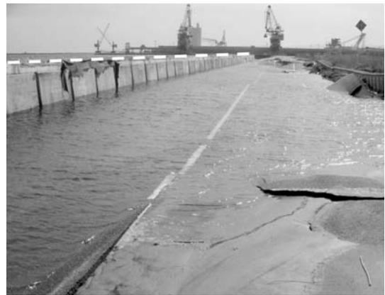
写真-2 沈下・浸水した港湾道路
