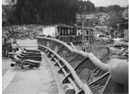
写真-4 高欄の被災状況
