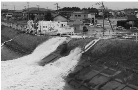
写真-1 排水ポンプ車による排水状況
