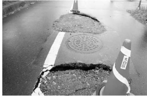
写真- 1 路面陥没状況
