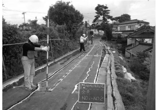
写真-5 堤体崩壊状況
