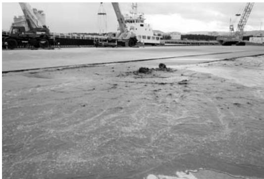
写真-2 岸壁背後液状化の状況(福島県より入手)
