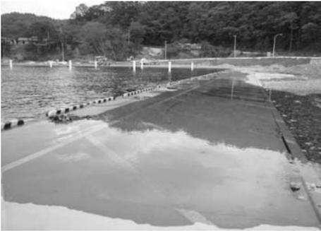
写真-5 満潮に近くなり水没し始める岸壁（箱崎漁港）
