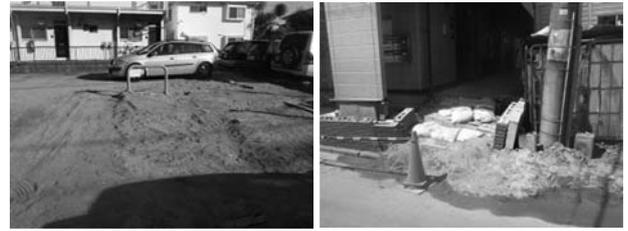
写真-1 液状化により堆積した土砂
