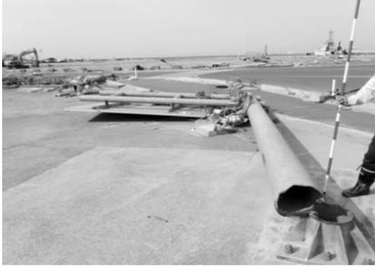
写真-4 標識柱の倒壊
