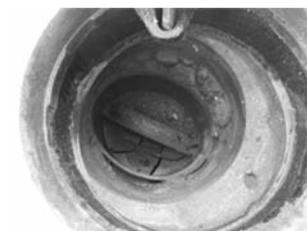
写真-4 枿内に堆積した土砂
