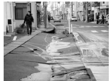
写真-1 管きょ埋設箇所の被災状況
