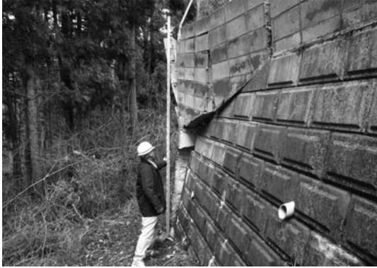
写真-1 間知石ブロック積+コンクリートブロック積の擁壁
