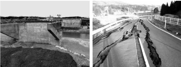
写真-1 海岸堤防や沿岸の道路は津波で流出し、橋桁は、路肩の崩落と地割れで通行不能となった。写真-2 内陸部の道路は、路肩の崩落と地割れで通行不能となった。
