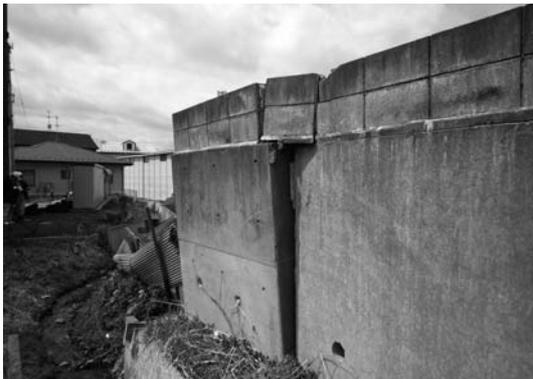
写真-2 用水に近い二次製品+コンクリートブロック積の擁壁
