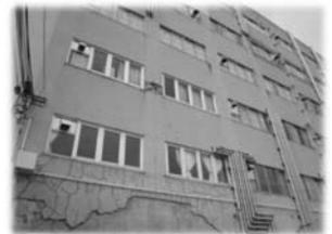
東庁舎：柱のせん断破壊が見られ、震災直後から使用不可
