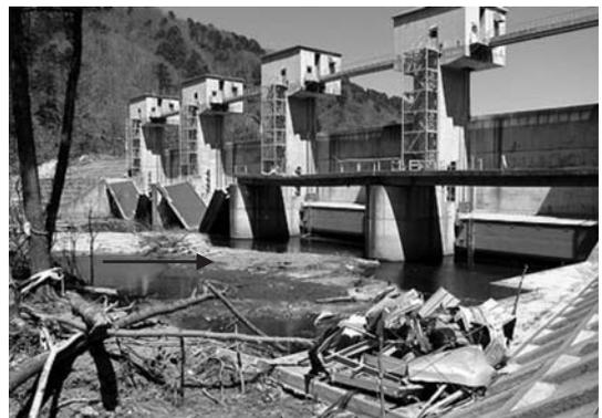
写真-3 普代水門操作室扉の破損
