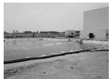
写真-3 県南浄化センターに設置した仮設沈殿池
