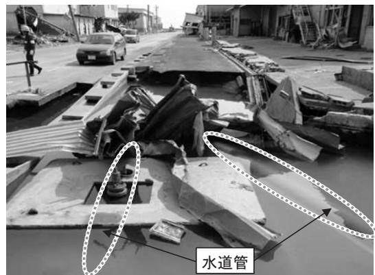
写真-1 津波により露出した水道管
