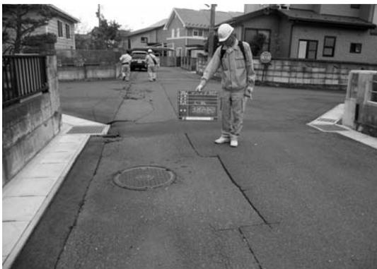
写真-6 管路上部の路面破損状況
