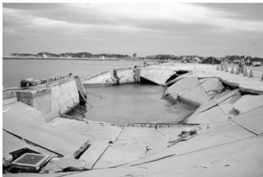
写真-3 岸壁の被災状況
