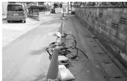
写真-2 陶管整備箇所の陥没
