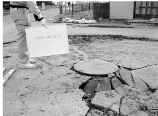
写真-3 人孔の被害状況
