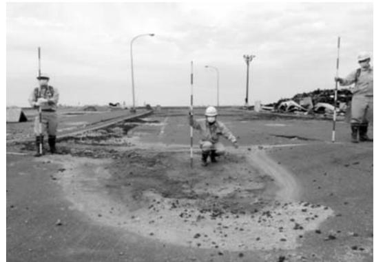
写真-2 舗装の陥没
