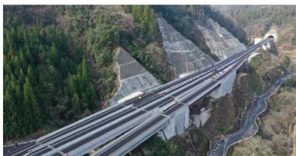
中津日田道路（耶馬溪道路：令和2年度開通）
