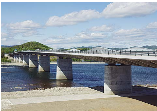
各務原大橋の全景
