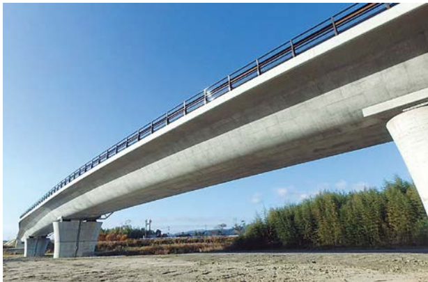
県道広野小高線天神大橋外観
