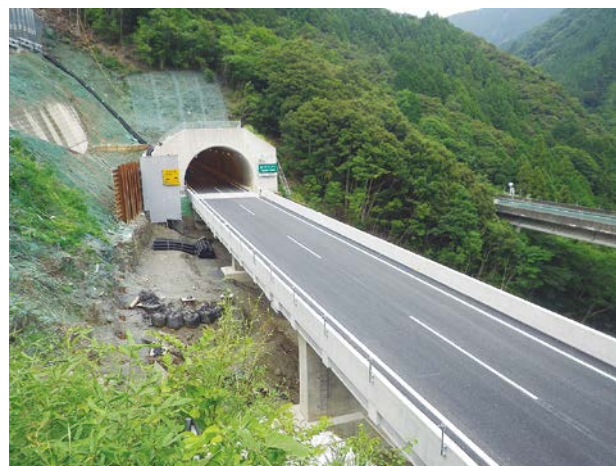
高知自動車道（立川橋）復旧状況
