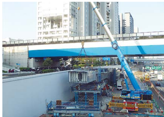
臨海副都心出口の桁架設の様子
