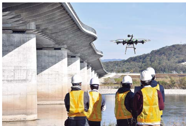
ドローンによる橋梁点検の様子
