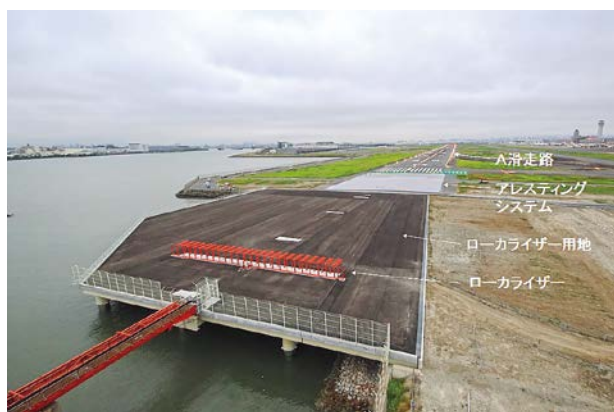
完成した用地及びアレスティングシステム
