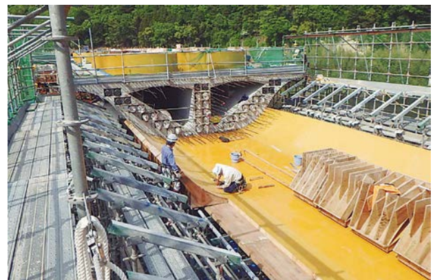
型枠（櫛枠）設置状況
