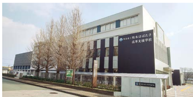
鉄筋コンクリート造（一部鉄骨鉄筋コンクリート造）4階建て 建築面積 3,240㎡ 延床面積 8,749㎡
