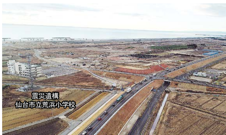
全線開通した東部復興道路
