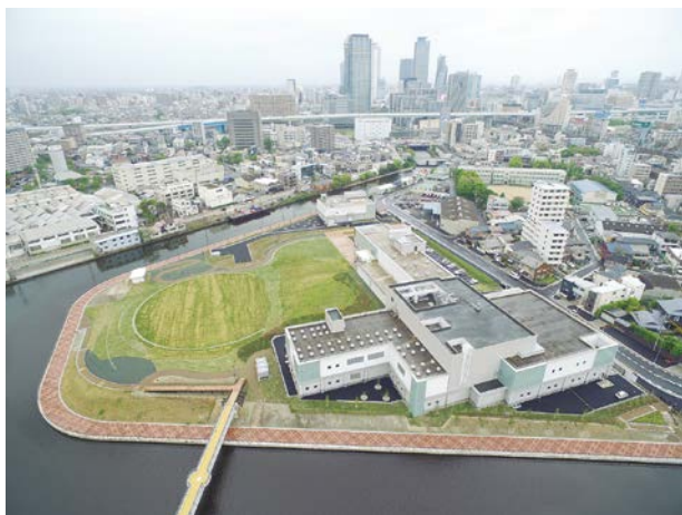
『広見憩いの杜』と改築後の露橋水処理センター
