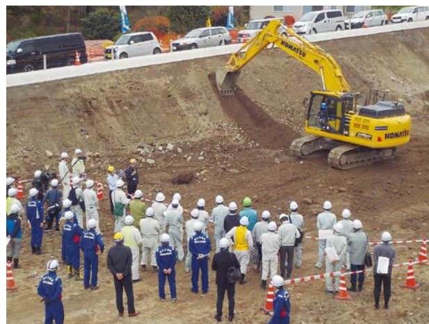
ICT土工研修会の様子
