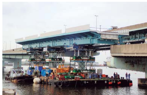
台船及び大型ジャッキによる桁架設の状況
