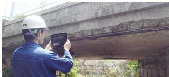
自治体職員による点検状況
