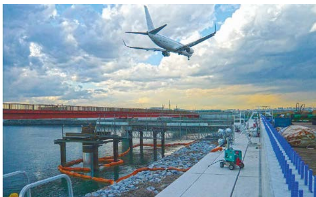
航空機進入経路の直近直下である施工箇所
