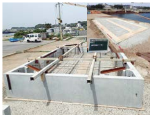
②【残置型枠ブロック函体組立】
