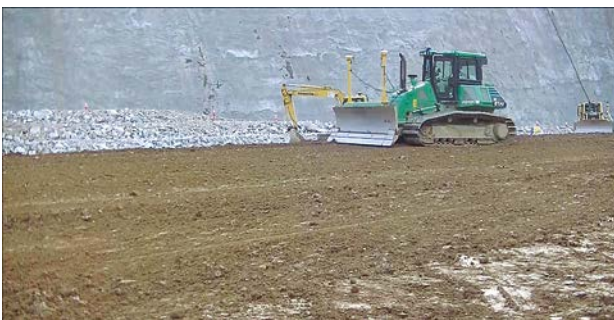
マシンコントロール搭載のコア施工状況
