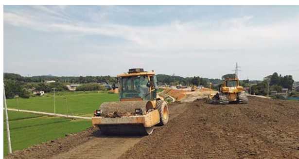
ICT施工の様子
