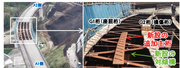
新設主桁の追加設置状況
