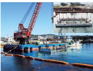
③【残置型枠ブロック水中設置】
