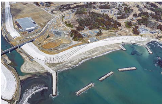
中島地区海岸の現況
