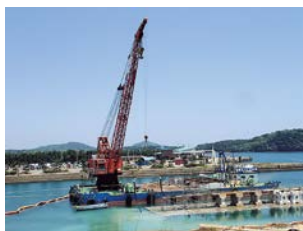
④【水中コンクリート打設】
