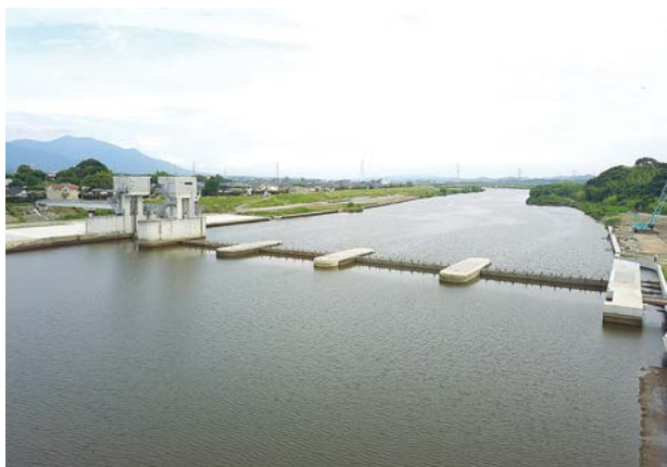
完成した新堰本体（平成30年6月）
