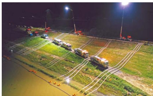
【宮城県大崎市】排水ポンプ車による24時間体制での緊急排水
