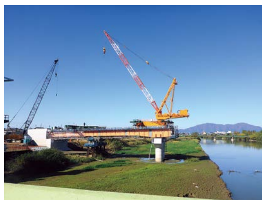
トラベラークレーンを用いた上部工工事
