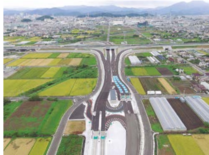
日本平久能山スマートIC完成写真
