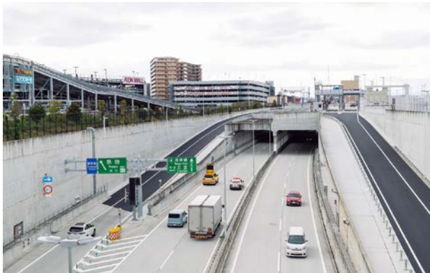
鉄砲ランプ付近開通（3月29日）の様子
