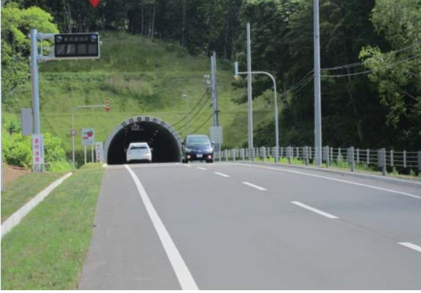
①主要道道余市赤井川線道路改良事業（冷水トンネル）
