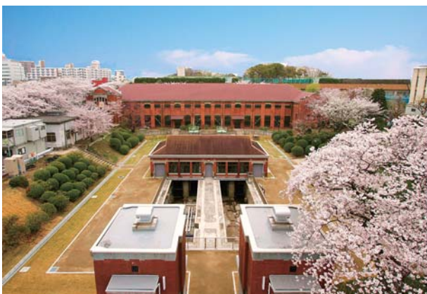
㉔国指定重要文化財「旧三河島污水処分場唧筒場施設」の復原・保存工事 ～わが国最初の近代下水道施設を公開・未来に継ぐ～
