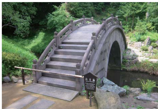
㉕都立小石川後樂園における円月橋修復事業
