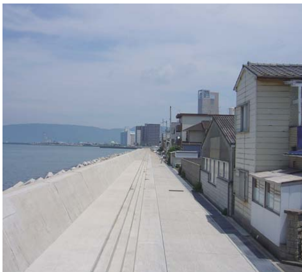
⑥高松港海岸直轄海岸保全施設整備事業（浜ノ町工区）
