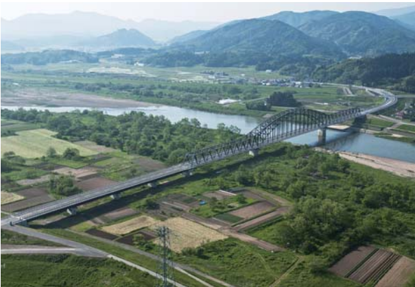
③一般国道 113 号館矢間バイパス整備事業
