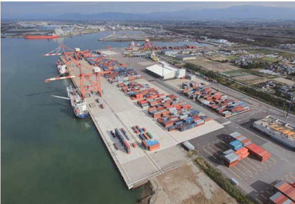
②新潟港国際海上コンテナターミナル整備事業
