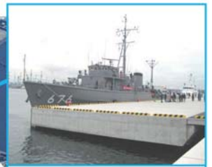
耐震強化岸壁 水深7.5m 延長130m (平成23年度供用済)
