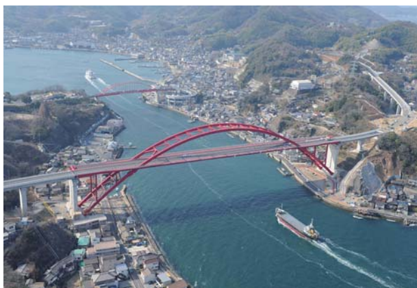
⑫一般国道 487 号橋梁整備事業 第二音戸大橋
