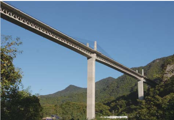
⑱ハツ場ダム建設事業 湖面2号橋
