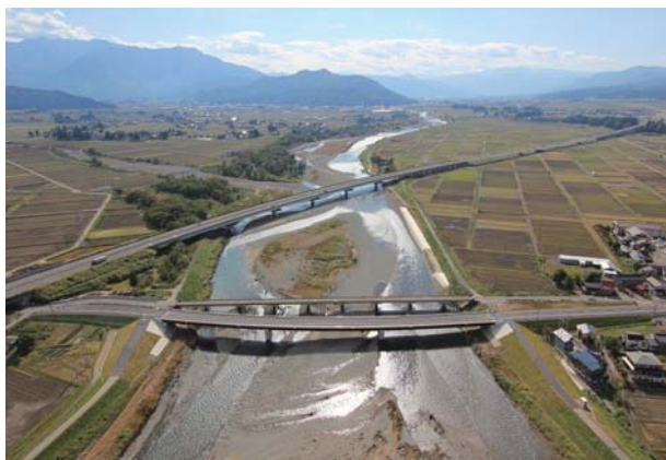
⑧一般県道桐沢麓五日町停車場線・八海橋（手前が新しい八海橋）
