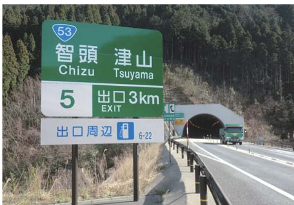
⑪鳥取自動車道整備と沿線地域一体となった利活用の取り組み
