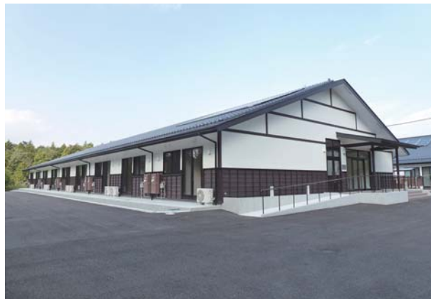
④相馬市馬場野地区災害公営住宅建設工事
