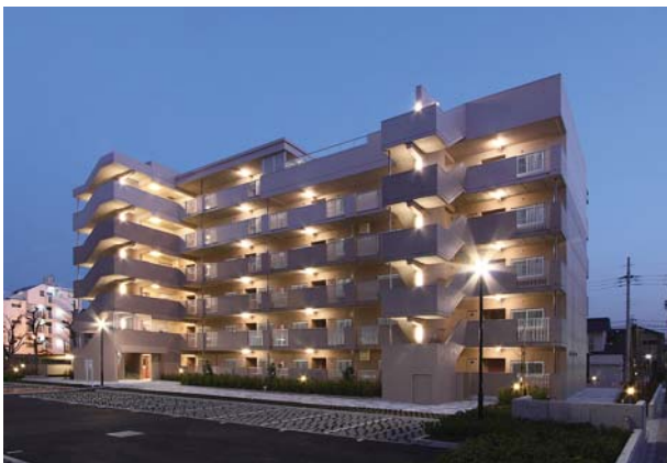
④県営紅梅住宅建設事業
