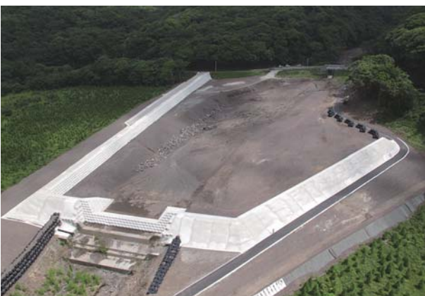
㉗大淀川水系直轄砂防事業 (荒襲川緊急仮設砂防堰堤)
