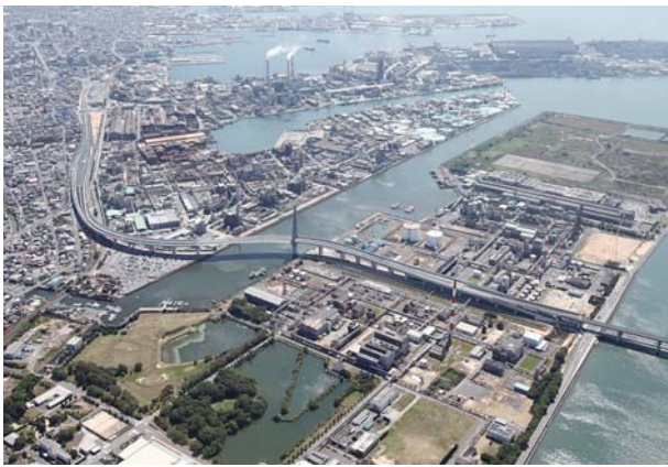
④宇部湾岸道路街路整備事業(地域高規格道路山口宇部小野田連絡道路)
