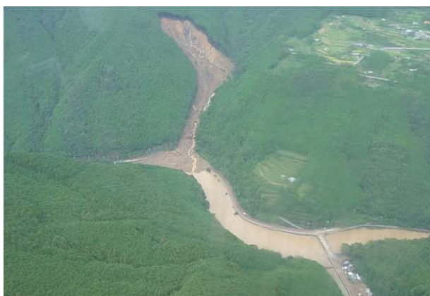
⑩国道 311 号道路災害復旧工事
