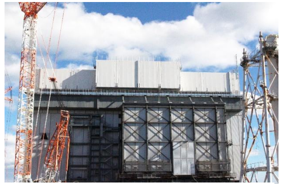
現在の福島第一原子力発電所 1号機
