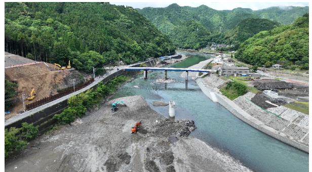
坂本橋の復旧状況
