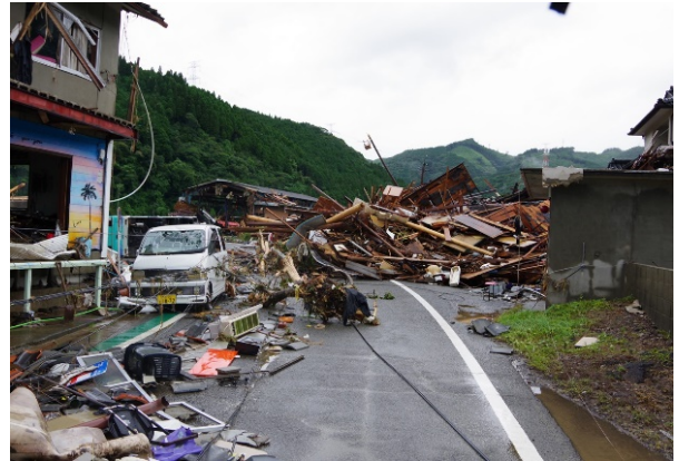
家屋倒壊の状況 (球磨村渡地区)
