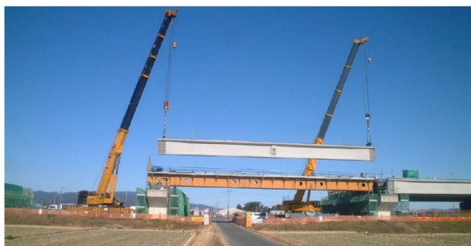
クレーン併用架設桁架設工法
