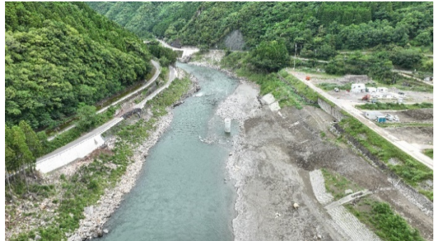
大瀬橋復旧状況
