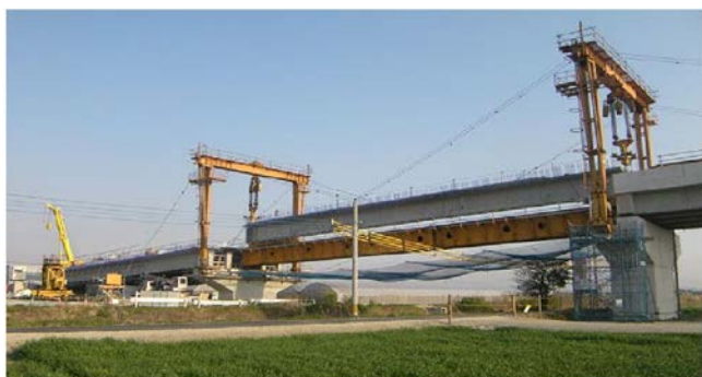
通常の架設桁架設工法
