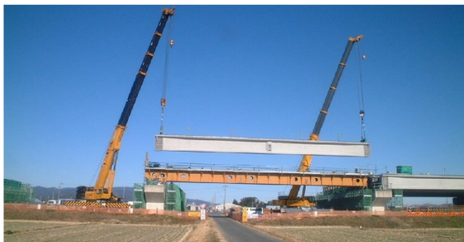
クレーン併用架設桁架設工法
