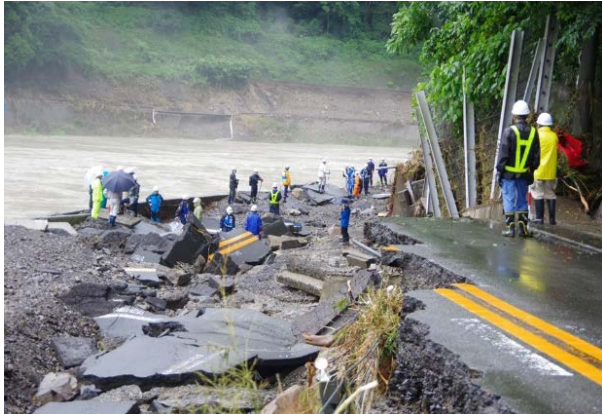
被災の状況 (国道219号 球磨村)
