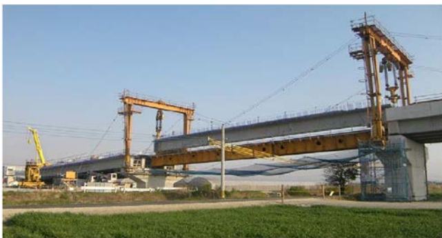
通常の架設桁架設工法
