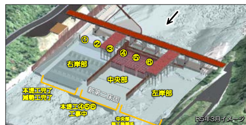
図4 第二床固改築工事の進捗状況
