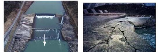
図2 老朽化が進行する第二床固
