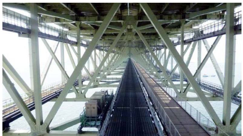
中央点検通路
