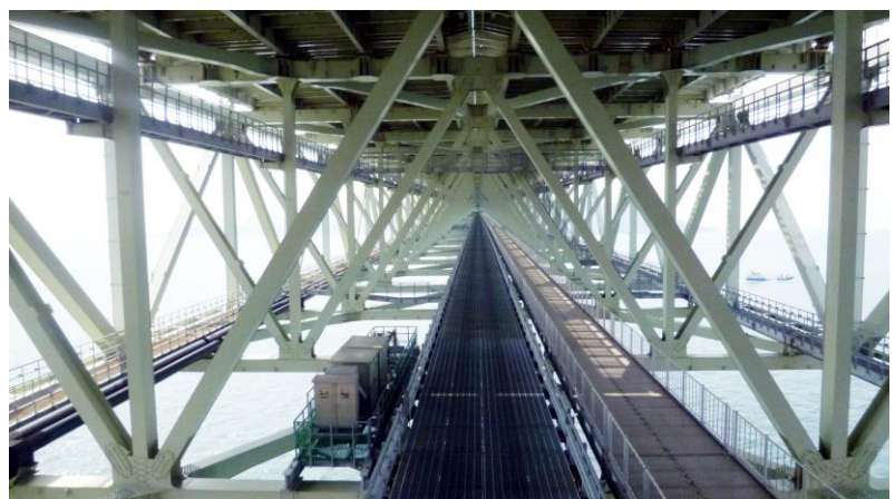
中央点検通路
