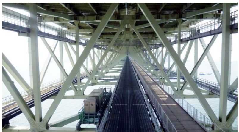
中央点検通路
