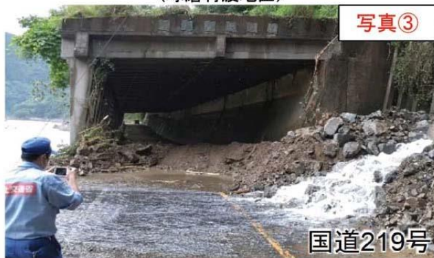
土砂流入により国道219号が被災 （球磨村渡地区）
