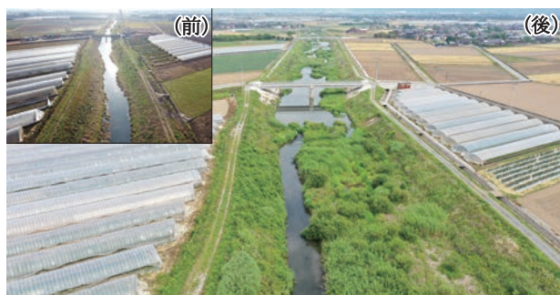
改修前後の桂川の様子
