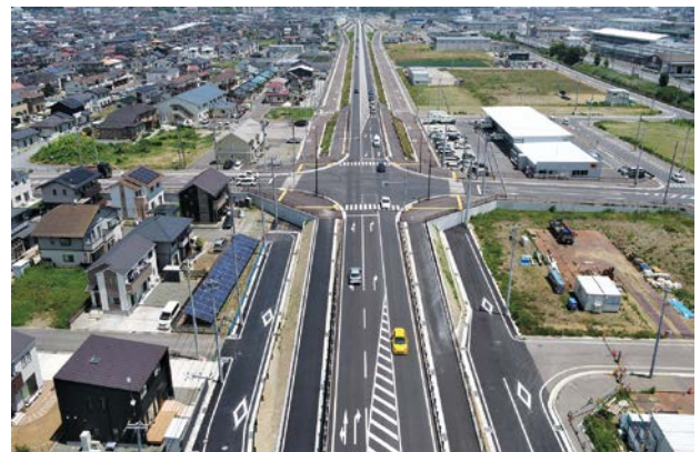
門脇流留線周辺の空撮写真
