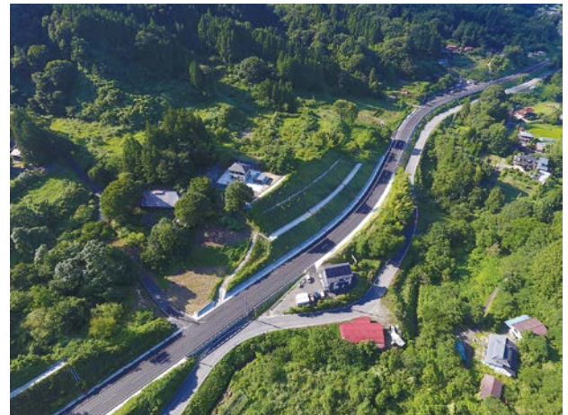
国道349号大綱木工区
