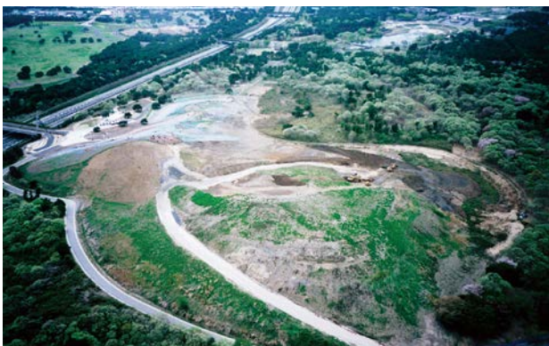
建設残土搬入が進み、その姿が現れた丘（平成13年）
