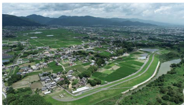
谷島工区（下流側）の堤防
