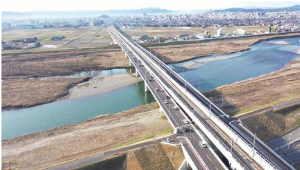
新九頭竜橋（中央は新幹線橋梁）
