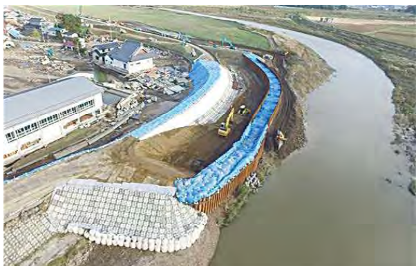
直轄鳴瀬川水系吉田川 緊急復旧完了
