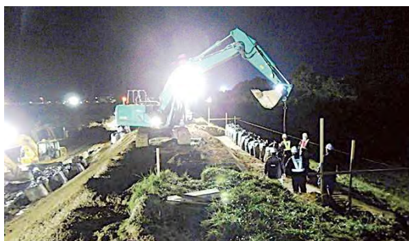
24時間体制による施工（阿武隈川内川 宮城県権限代行）
