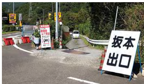
坂本PA(下)緊急開口部設置状況
