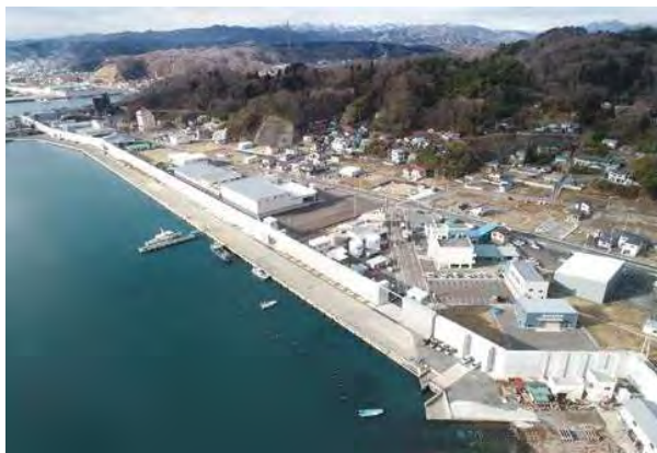
防潮堤の空撮
