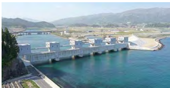
完成した気仙川水門
