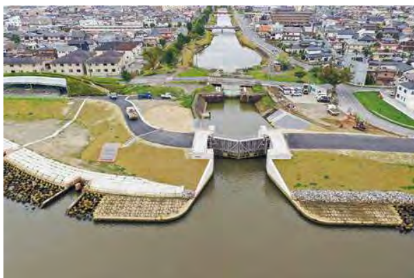
石井水門（手前）と石井閘門（奥）
