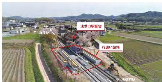
行き違い施設全景
