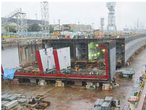
ドックにおける沈埋函（鋼殻）の製作状況
