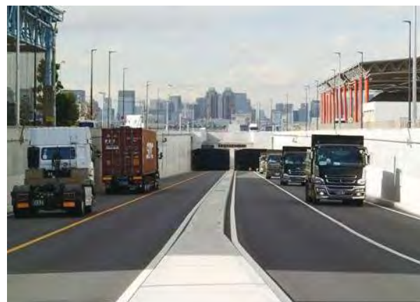
供用後の「海の森トンネル」（中央防波堤側）
