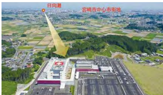
宮崎市医師会病院等を沿岸部から直線距離約9kmの標高約29mの高台へ移転
