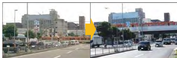
(都)小曾根線（西開踏切）整備前後の状況
