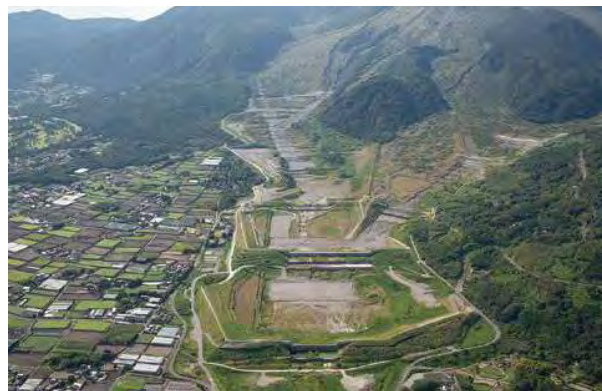
水無川上流域の砂防設備群（2020年11月）
