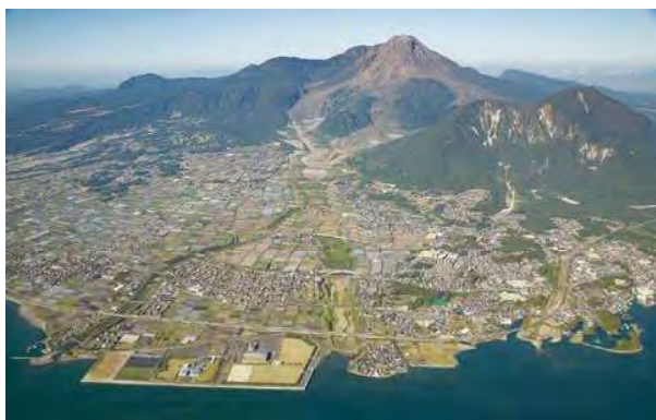
水無川流域の砂防設備全景（2020年11月）
