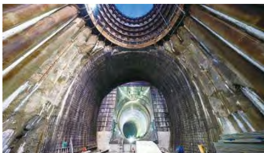
変位を観測しながら掘り終えた立坑
