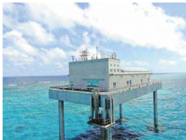
新観測拠点施設の設置状況
