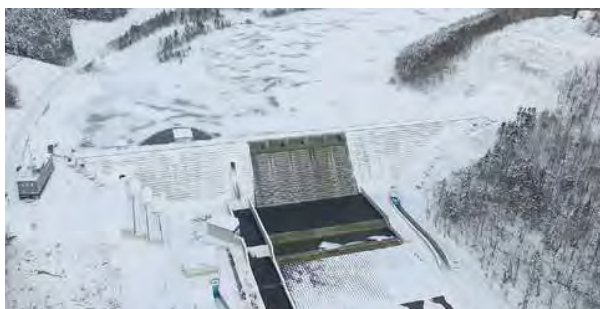
試験湛水中のサルダム
