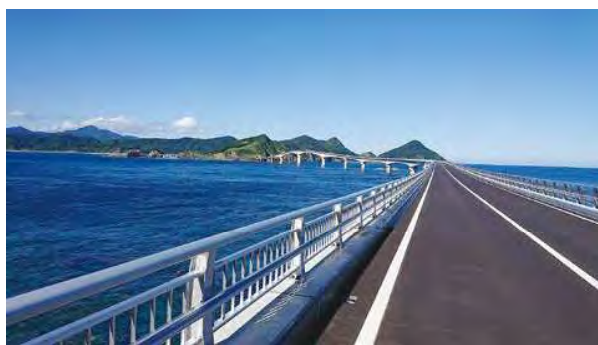
完成した甌大橋橋上から
