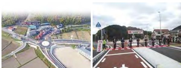
環状交差点完成写真及び供用開始時の開通式の様子
