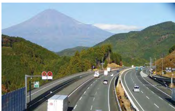
新東名 6車線化完成後の様子
