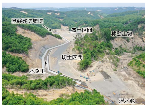
緊急対策工の完成状況
