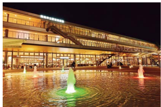
地域エネルギーを活用した夜の景観
