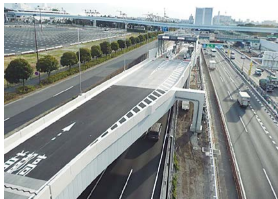
臨海副都心入口完成の様子
