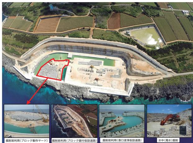
掘削岩を埋め戻したブロック製作ヤード
