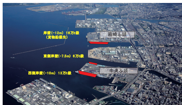
整備前のクルーズ船受け入れ施設
