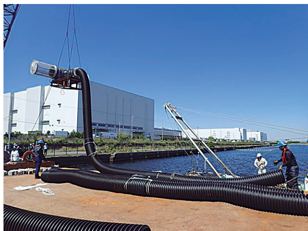
ポンプ式底層放流装置（堺泉北港堺浜）
