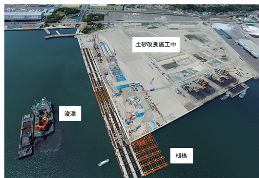
第3ふ頭地区全景（浚渫・栈橋・土砂改良施工中）
