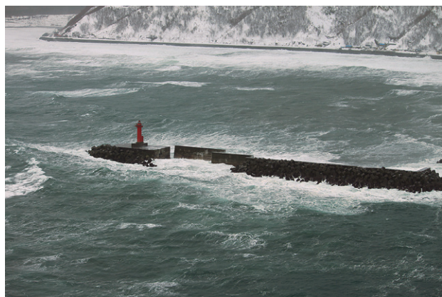
島防波堤の被災状況
