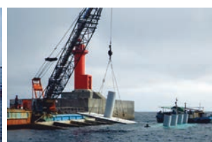
浮上蓋設置状況
