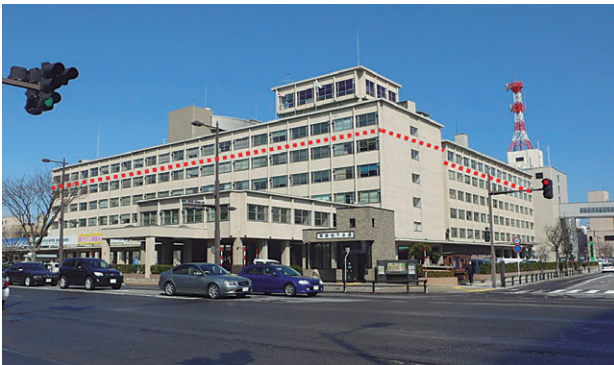
改修前の県庁舎（6階以上を減築）
