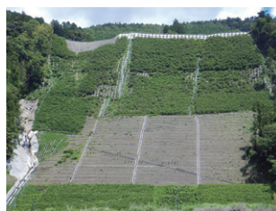
工事完成後（R1.6.13）
