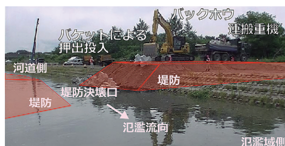
重機による効率的な資材投入検証
