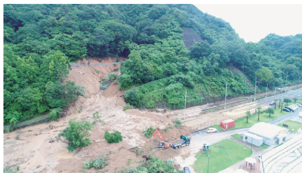
被災状況（広島呉道路）
