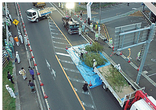
現道を全面通行止した倒木撤去訓練
