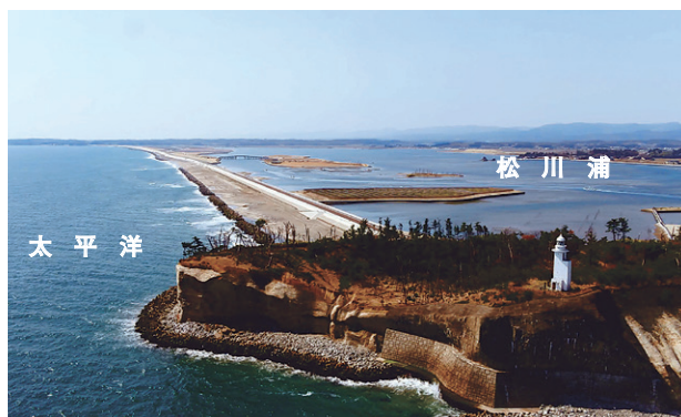
復旧後の状況
