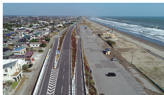
九十九里有料道路かさ上げ工事完了後の状況
